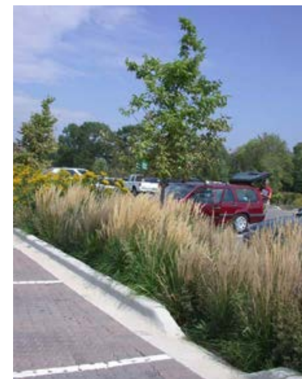
↑ Kombinace zatravněného svejlu a dešťového záhonu ↓ Odvodnění plochy parkoviště do retenční rýhy s vegetací
