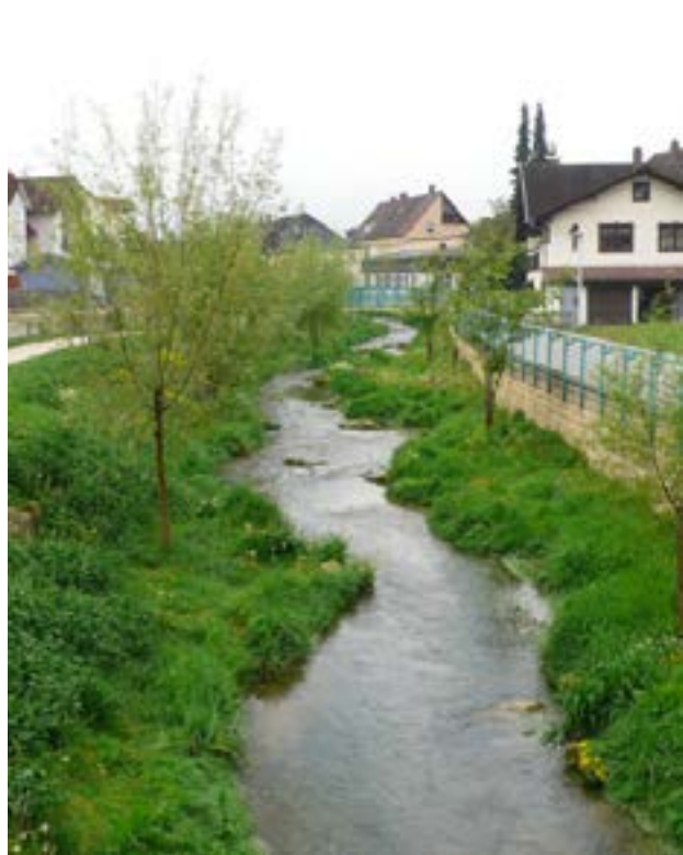
↑ Revitalizace koryta v obci Bad Staffelstein vytváří průtočnou kapacitu potřebnou pro ochranu okolní zástavby před povodněmi, přitom je přírodě blízkého charakteru, dokonce s výsadbami stromů.
