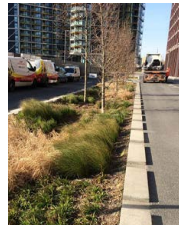
↑ Plocha odvodňující přilehlé zpevněné povrchy ↓ Svejl, do kterého je skrz dávanou obrubu svedena voda z chodníku a vozovky
