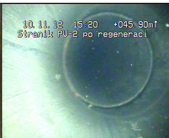
Přechod na užší výstroj v hloubce 45,90 m
