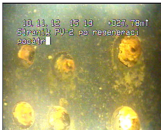
Detail počátku perforace v hloubce 27,78 m
